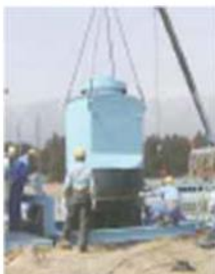
設置工事の様子
