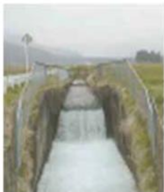
発電機設置前の水路
