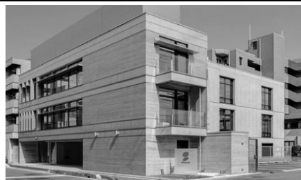
山崎建設株式会社東京支店*
