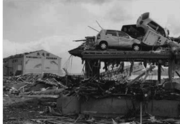
被災状況（歌津地区）
