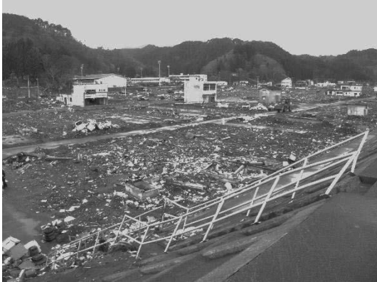
宮古市田老地区の被災状況
