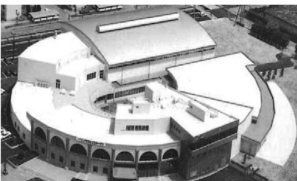
水島スポーツセンター
