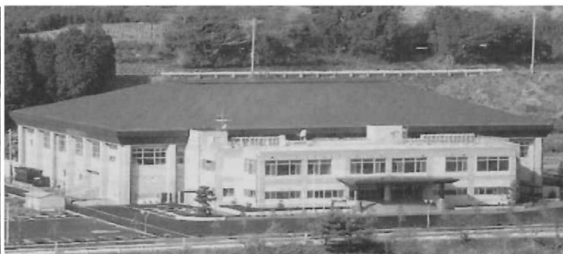
富士川町総合体育施設
