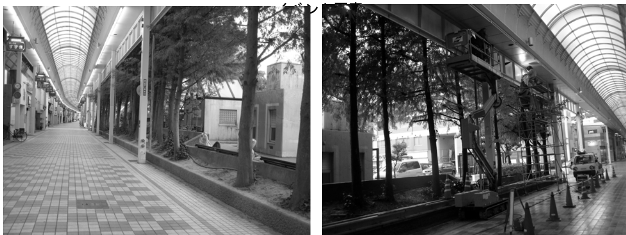
写真 改装前の様子
