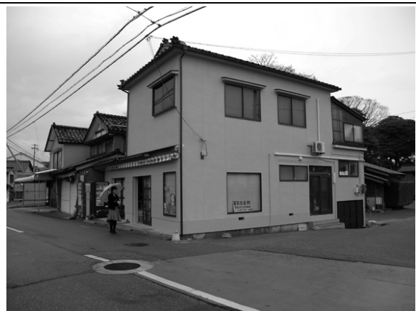
外壁塗装後(側面)
