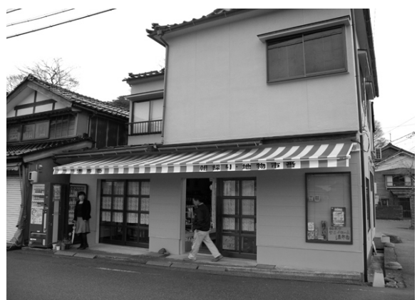
外壁塗装後(正面)
