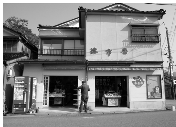
外壁塗装前(正面)
