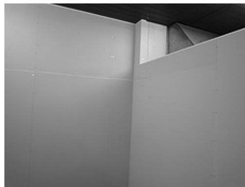
ボードを貼り、壁を立ち上げる
