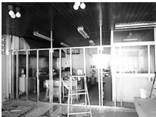
奥に壁面を設置するための柱を設置
