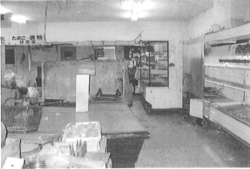
解体中のヨシダ本店
