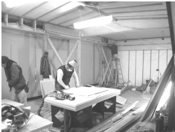
内観改修工事状況②
