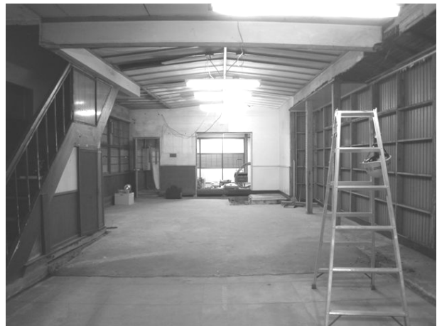
内観改修工事状況③
