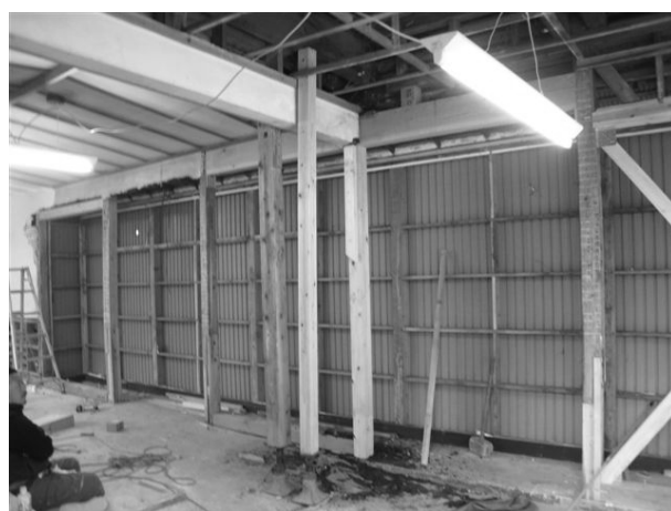
内観改修工事状況①
