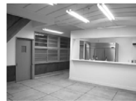
1階店舗内部 (改修後)
