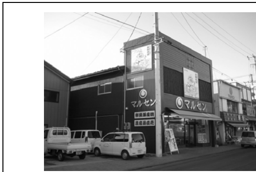
改装後の外装
